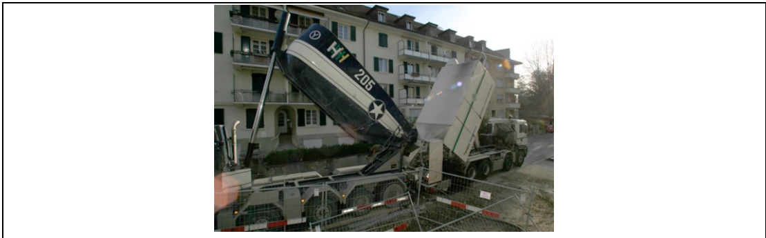
Abbildung 2: Mischung des Bindemittels mit Sand auf der Baustelle (Bild: KBS, Veltheim)
