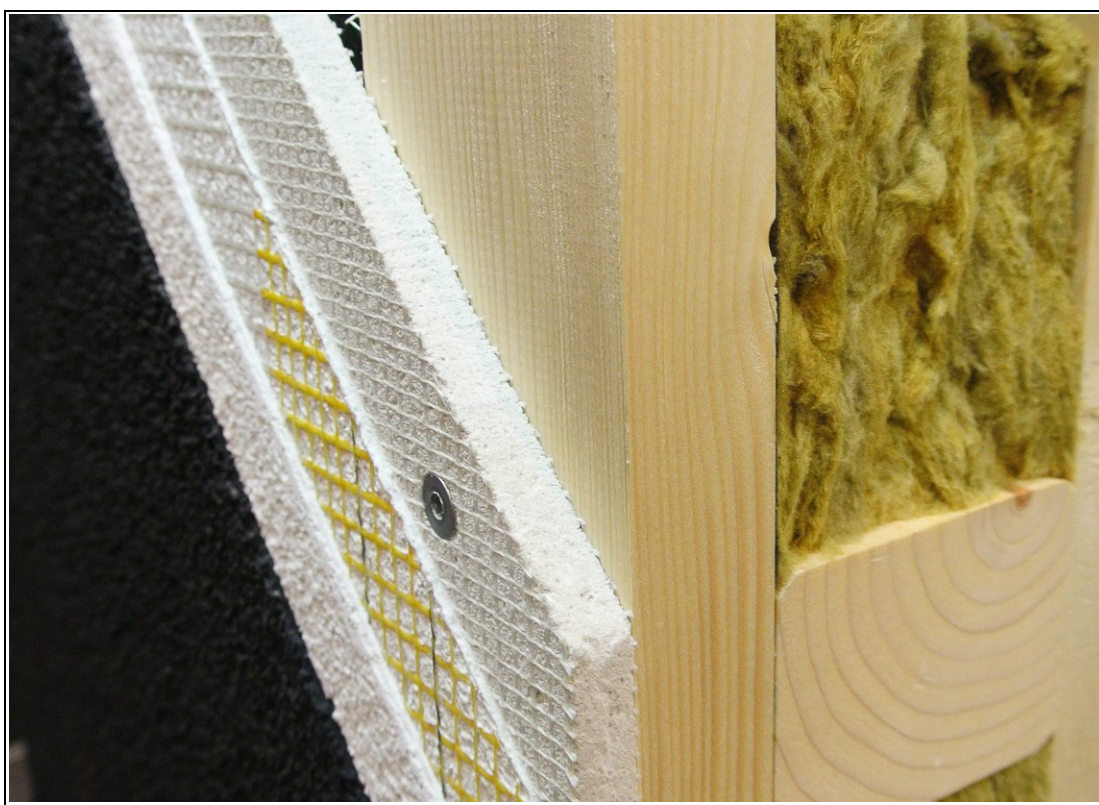
Abbildung 1: Modell Wandaufbau mit StoVerotec Putzträgerplatte direkt auf einem Holzständer und Putzaufbau mit Armierungsgewebe, Deckputz und Anstrich
